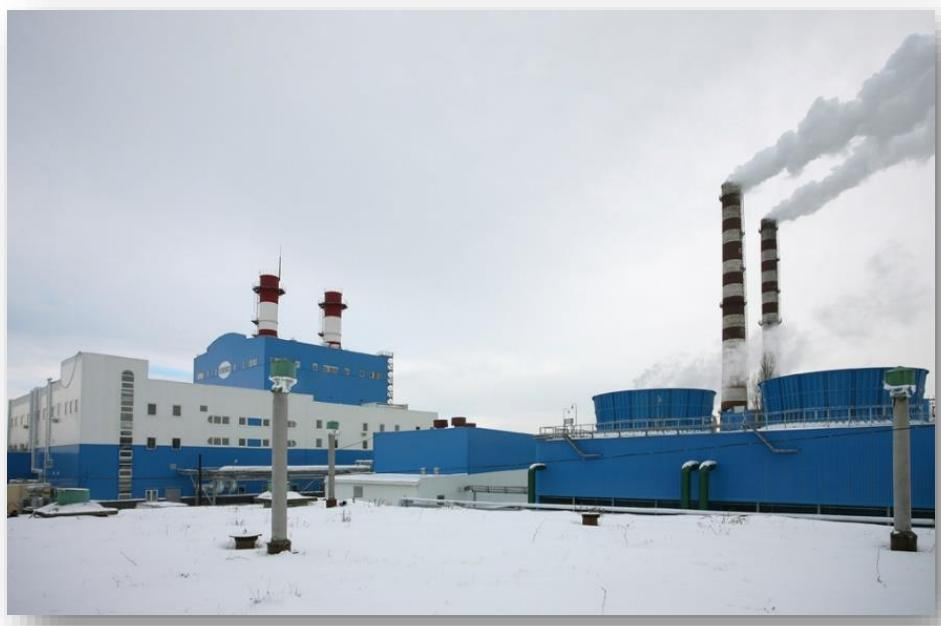
ТЭЦ СЗР является самой «**молодой**» станцией Курска. Изначально она возводилась как котельная для обеспечения нужд строящегося Северо-Западного района города. В **2008** году началась масштабная реконструкция, в ходе которой на котельной была построена парогазовая установка мощностью **115 МВт**. В настоящее время станция снабжает тепловой энергией и горячей водой наиболее густонаселенные районы Курска: Северо-Западный, Юго-Западный, СХА, проспект Победы и другие.
